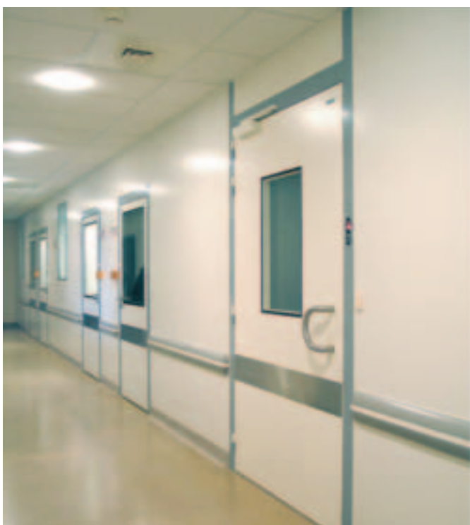
Vue sur un couloir d'accès : nécessité de portes correctement dimensionnées pour permettre la circulation des gros matériels
