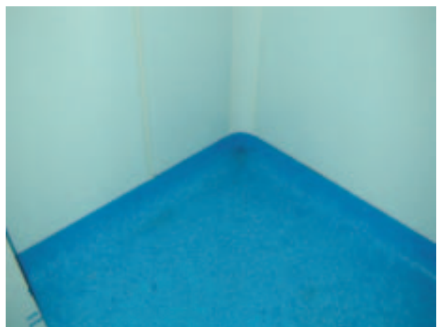
Finition d'un sol en plastique thermosoudé gorge arrondie et remontée en plinthe
