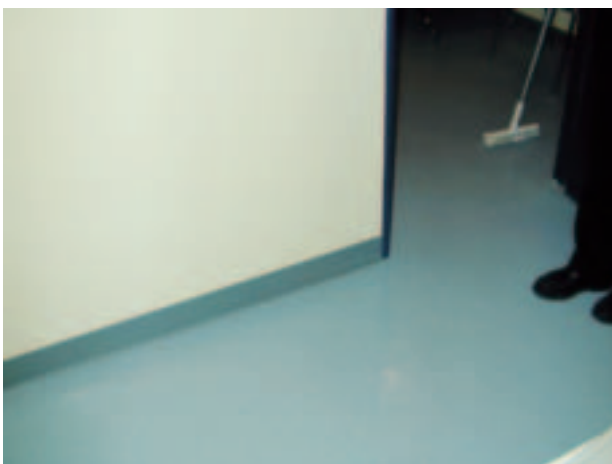
Finition d'un sol en résine
