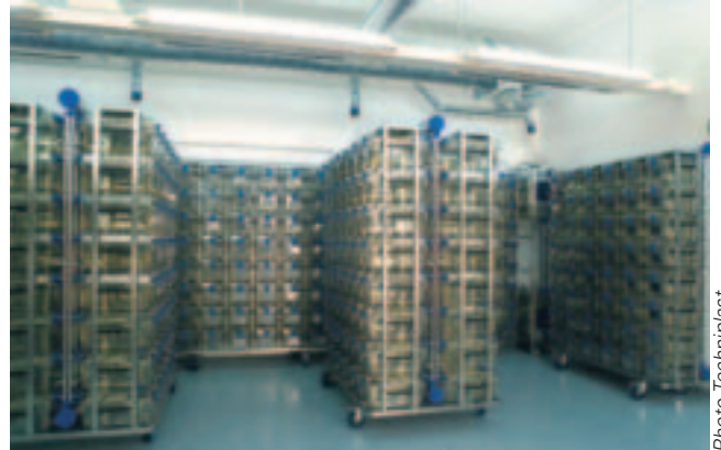
Ensemble de portoirs ventilés avec extraction raccordé sur le circuit général
