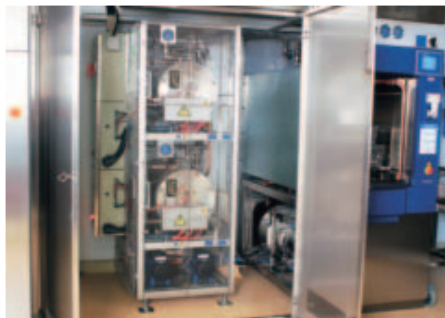
Vue d'un générateur de vapeur pour autoclave double entrée
